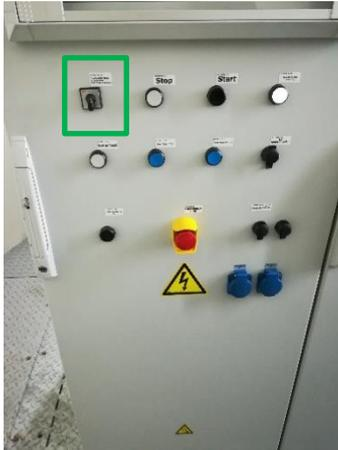
Armario convertidor, se destaca el selector de las comunicaciones
