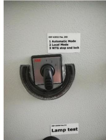
Selector de comunicaciones con la medialuna instalada y en posición 1 o 'Remoto'
